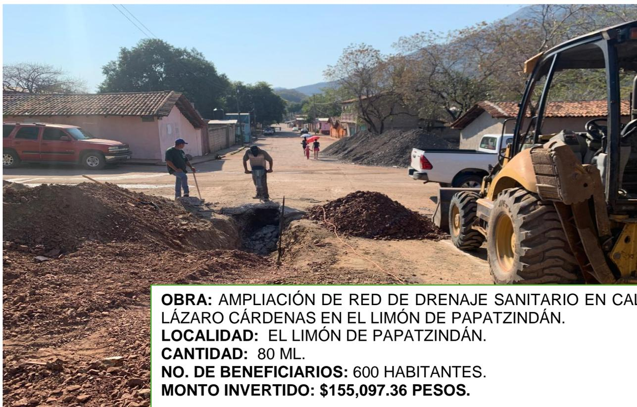
**OBRA:** AMPLIACIÓN DE RED DE DRENAJE SANITARIO EN CALLE LÁZARO CÁRDENAS EN EL LIMÓN DE PAPATZINDÁN.
